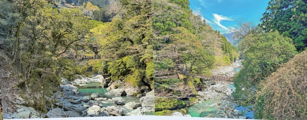
照片 9 祖谷葛藤橋
