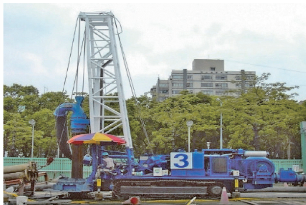
圖 2 履帶式 S-600 反循環機施工（同豐營造提供）
