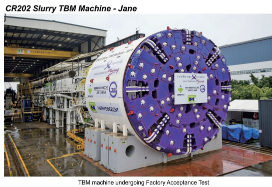
圖 9 新加坡地鐵所使用的大圓潛盾機
