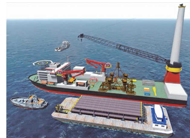
圖 11 海上打樁 (Jacket Pile) 施工團隊 (摘自 JDN, 中興顧問提供)
