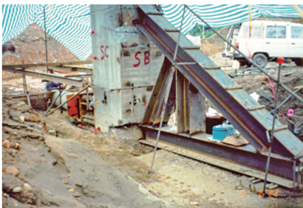
圖 20 台灣首例「樁頂旋轉束制」側向載重試驗 (1991, 台安技術提供)
