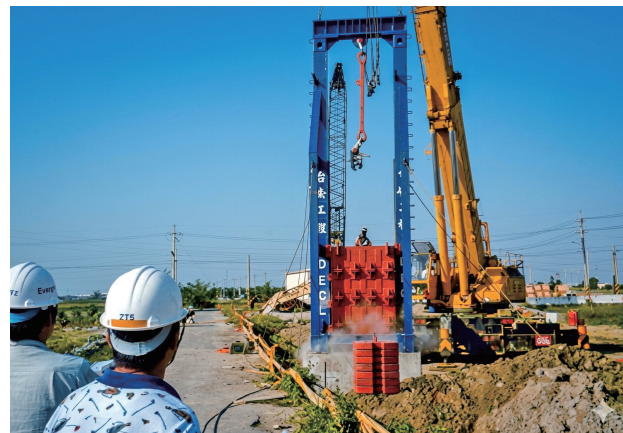
圖 25 使用 44.6T 落錘進行鑽掘樁 DLT 試驗 (2000, 高鐵 C291 標, 台安技術提供)
