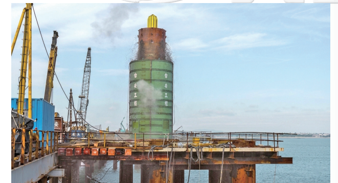
圖 23 海上靜動壓力載重試驗 (2015, 金門大橋, 台安技術提供)
