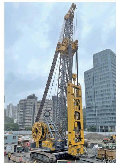
圖 6 雙滾輪鑽掘機 (同豐營造提供)
