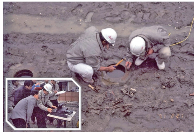
圖 15 PC 樁低應變完整性試驗防潮堤加高工程（1991，台安技術提供）
