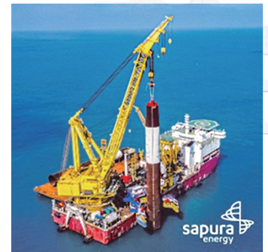
圖 12 Monopile 施工船機 (摘自 Sapura, 中興顧問提供)
