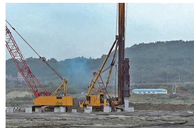
圖 1 台北港鋼鐵廠房基礎—打擊式 PC 樁施工（曾孝欽攝）
